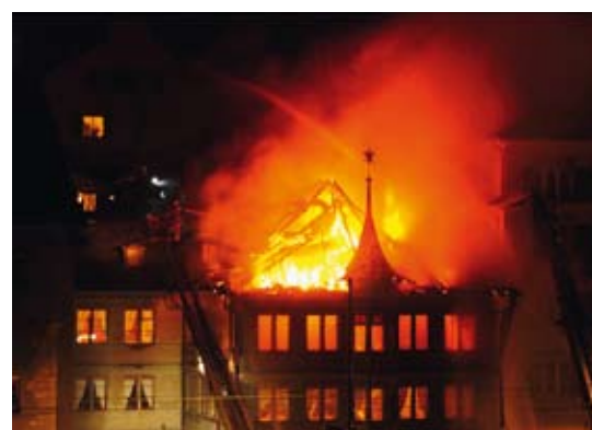
Kurz nach Mitternacht brennt der Dachstock in voller Ausdehnung.
